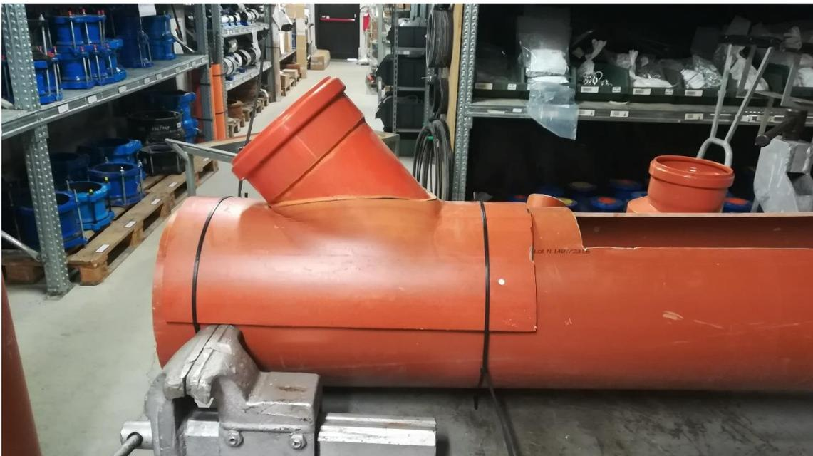
Il candidato dovrà accertarsi che la derivazione sia centrata rispetto alla finestra del tubo, prima di provvedere al fissaggio definitivo e anche dopo per evitare che la braga si sia mossa.
